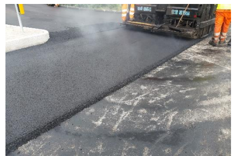
Figura 1 Un particolare della stesura dell'asfalto
